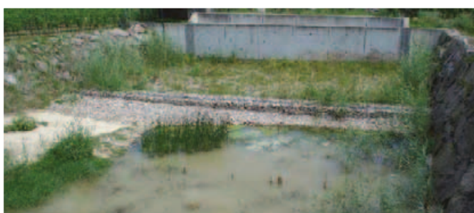
Jezírko na srážkovou vodu
